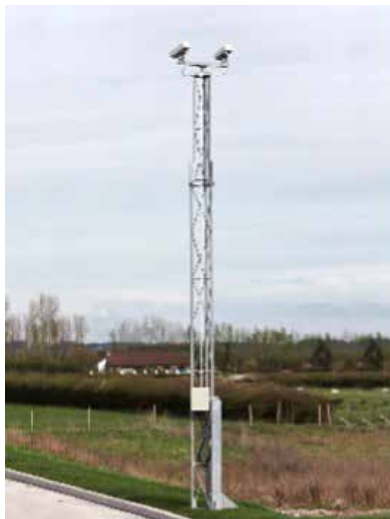
Torre Altron construcción de celosía
