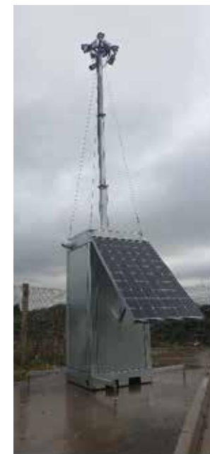
Einzelnes Solarmodul auf dem Turm
